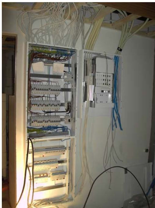
Установка кабеля в технической комнате дома в процессе
