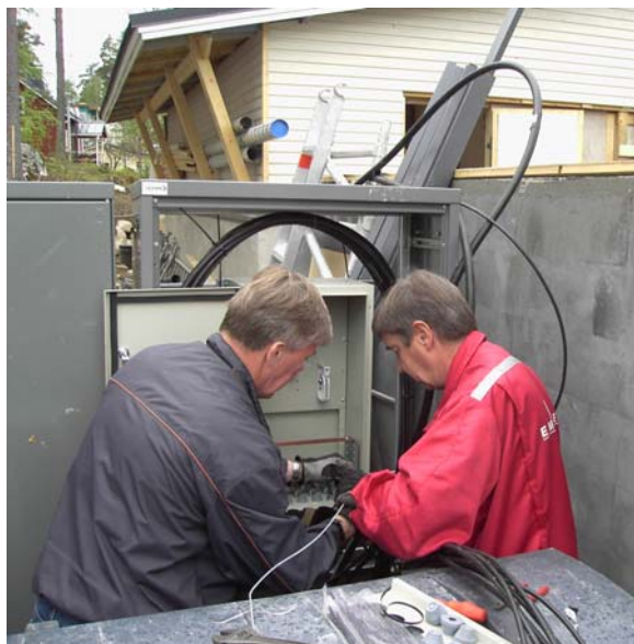
Установка шкафов для сварных соединений в процессе
