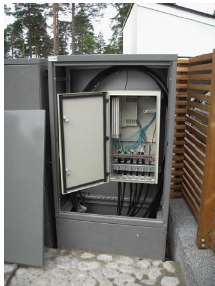
Установка шкафов для сварных соединений завершена
