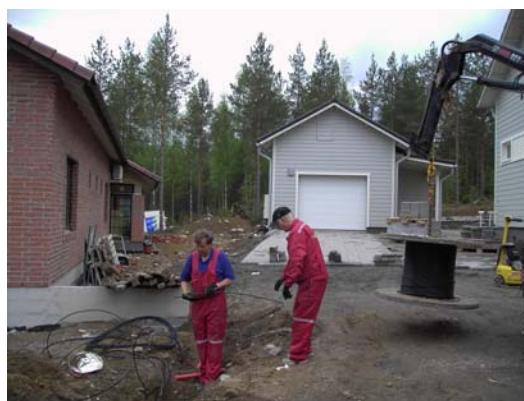
Прокладка кабелей к домам
